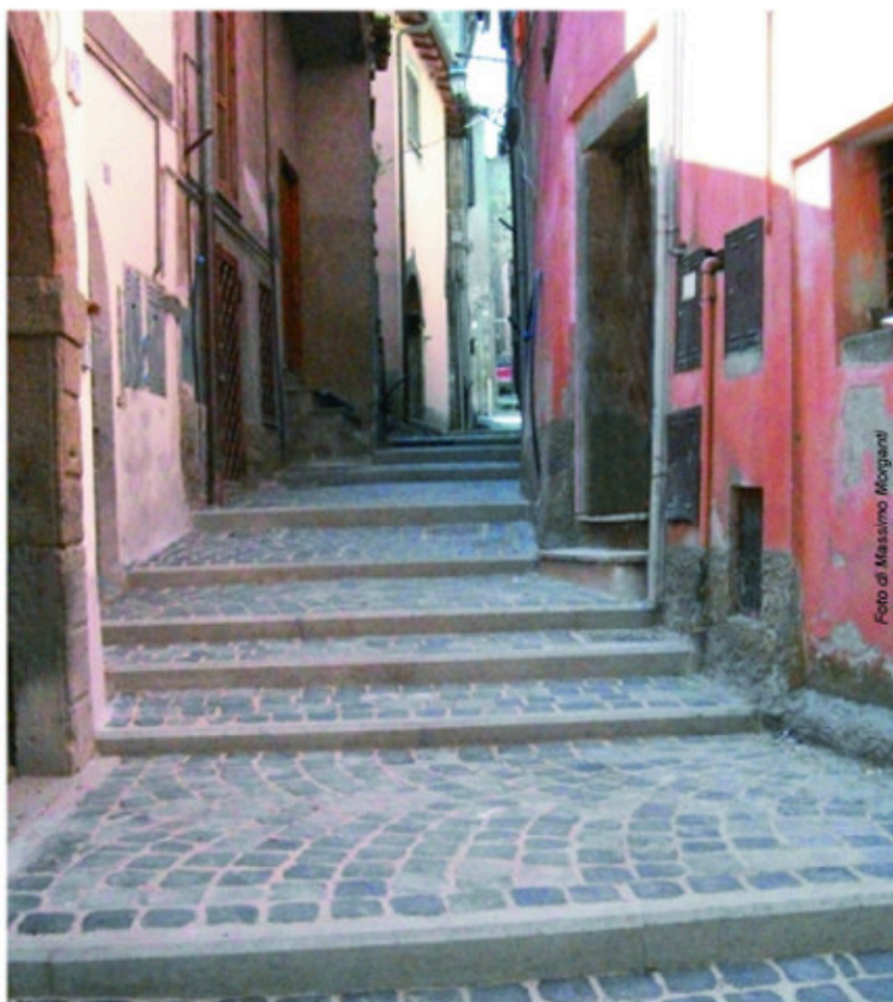
Un tratto della nuova pavimentazione nel Centro storico
